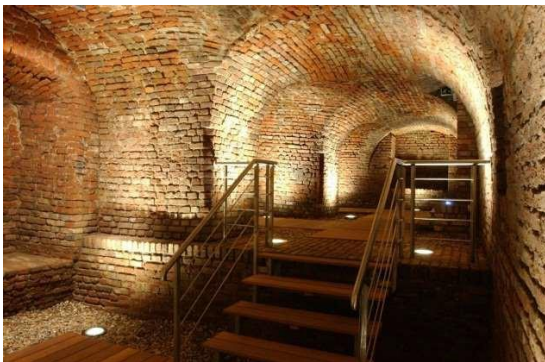
Unterirdische Festungsanlage unter dem Koenraad Bosman Museum
